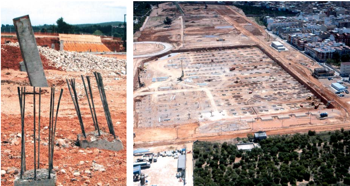
Carcaixent Shopping Centre Foundations (Valencia)
