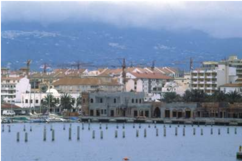
Fuengirola Marina Dock Foundations (Málaga)
